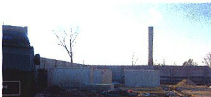
Gradilište objekta Pritvorske jedinice, novembar 2004.
