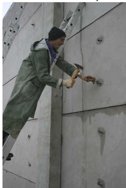
Izgradnja pritvorske jedinice
