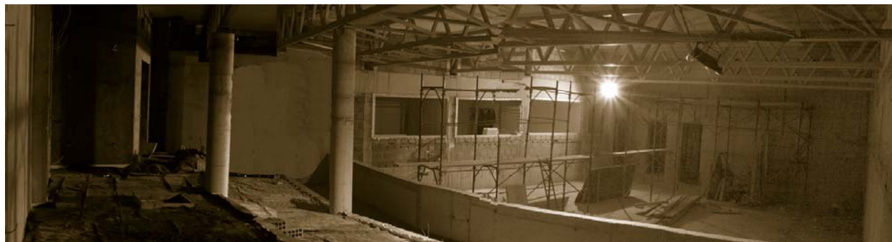
Oktober 2005. godine: fotografija gradilišta nove sudnice sa visokim stepenom osiguranja, koja se treba dovršiti u decembru 2005. godine.
