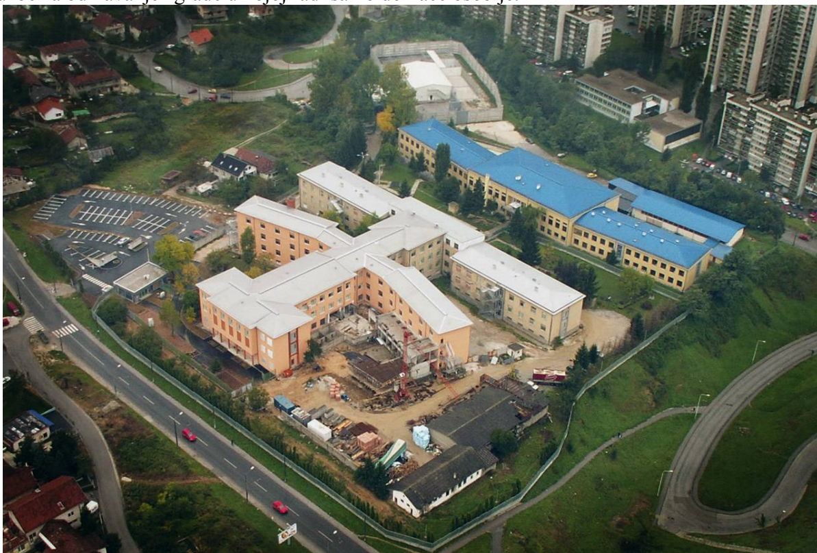
Sud i Tužilaštvo BiH, te Pritvorska jedinica Ministarstva Pravde BiH. Na slici se vidi i gradilište sudnice 6 sa visokim stepenom osiguranja.
